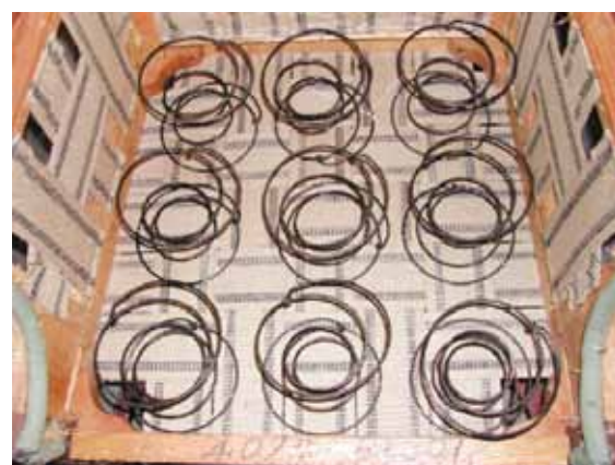
Τοποθέτηση σούστας ταπετσαρίας και στρωματοποιείας
