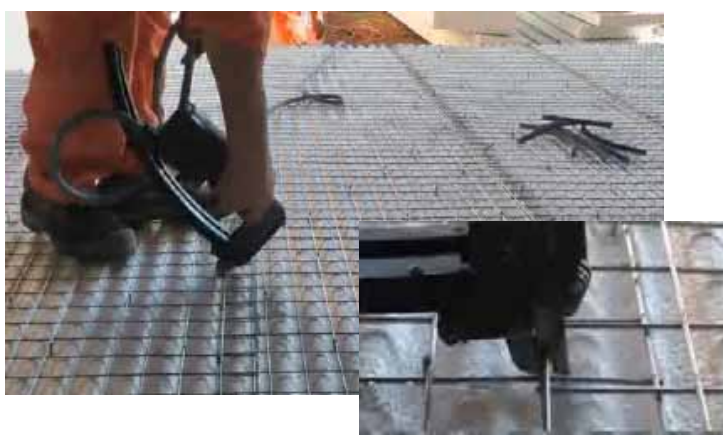
Συρραφή πλεγμάτων τοιχοποιίας και μονώσεων
